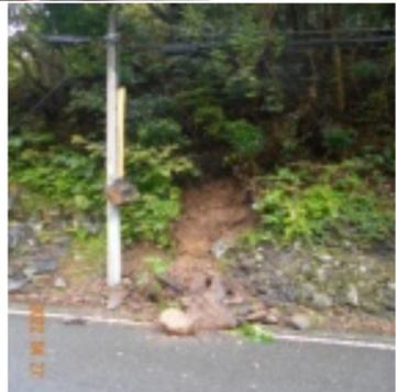
4/27(水) 早朝に8組国府田家の入口階段の下側で、電柱支線のアンカー部分の法面が崩落した。市役所に連絡し即日対応により、業者が土砂撤去済みにて交通への影響はなかった。
