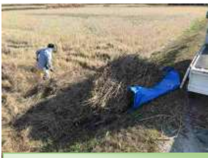
2020.02.12 山草運搬・敷き均
