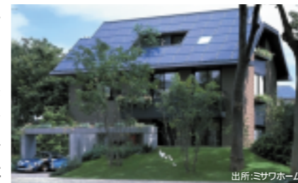
写3 屋根と一体化した太陽光発電システム
