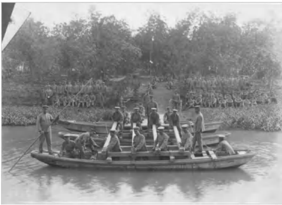
ボートを利用して橋架設
