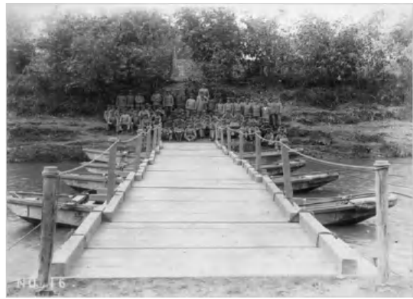
左完成負荷重量約 2200 トン
